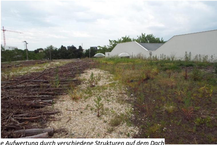
Ökologische Aufwertung durch verschiedene Strukturen auf dem Dach
