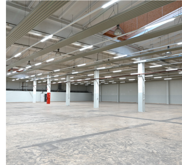
Ansicht Halle innen
